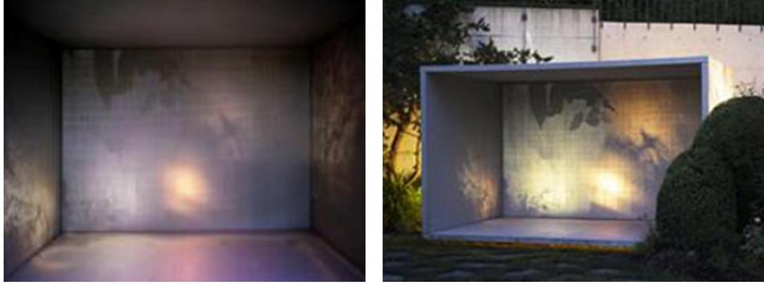
شكل رقم (4): توضح اثر الخرسانة الشفافة قبل وبعد وجود الاضاءة
