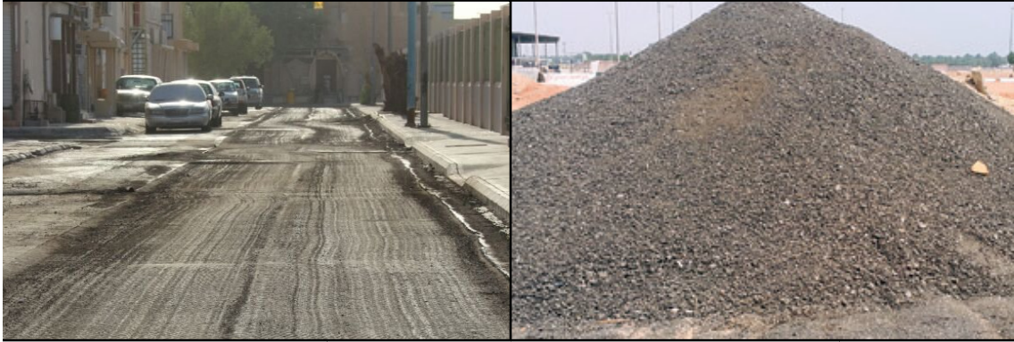
شكل 3 شكل الطريق بعد الكشط
