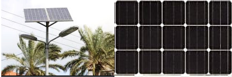
شكل رقم (7) نوع الإنارة واللوح الشمسي لطريق مزدوج عرض (12-20 م)
