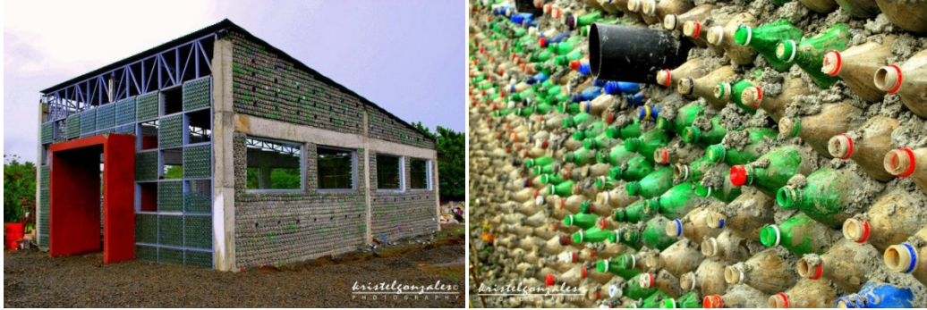
شكل (6) : مدرسة مصنوعة من زجاجات بلاستيكية مملوءة بالطين
